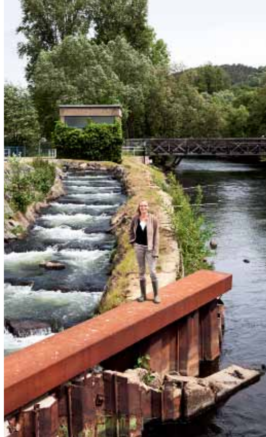
Mit ihrer Fischtreppe macht Antje Goedeking, 44, das Wasserkraftwerk Obermaubach naturverträglicher
